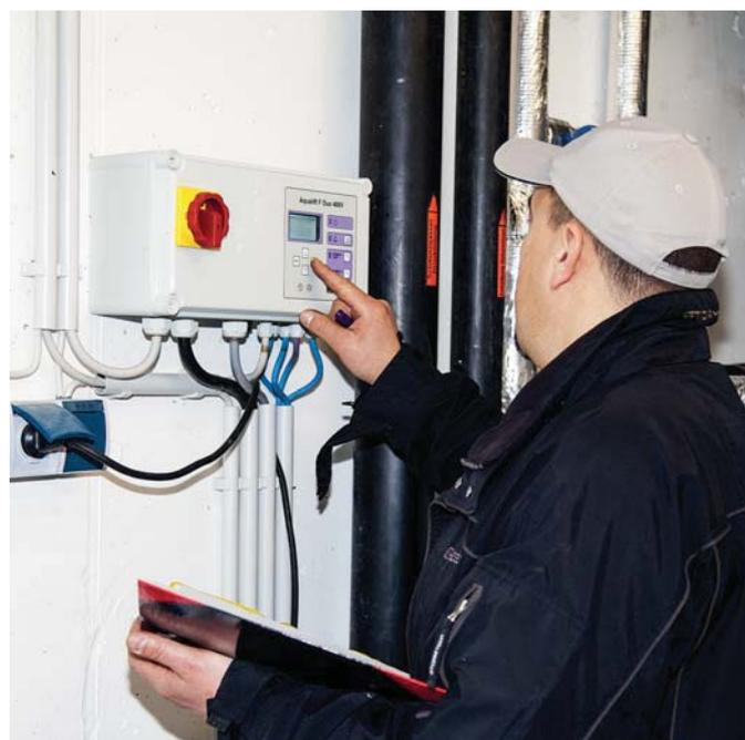
KESSEL propose de nombreuses variantes en matière de coffrets de commande et de sondes et capteurs de niveau adaptés à tous les besoins et contraintes. Possibilité également de connecter ces équipements à des systèmes de GTB/GTC.
