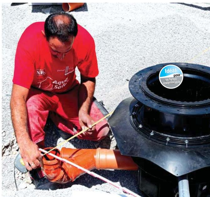
Les postes de relevage *Aqualift S* pour la pose dans une dalle / un plancher en béton évacuent les eaux de surface ou suite à une inondation ou un défaut de canalisation par une commande de pompe entièrement automatique.
