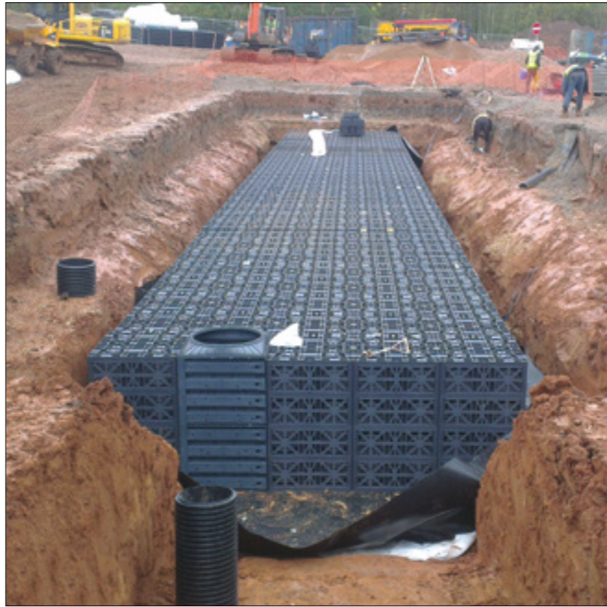
Fournisseur d'énergie, Warwick (Royaume-Uni)
