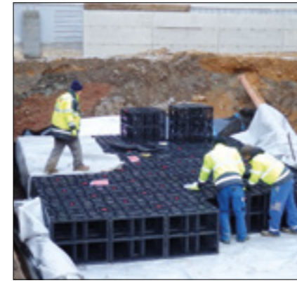
Bâtiment industriel, Tumeltsham (Autriche)
