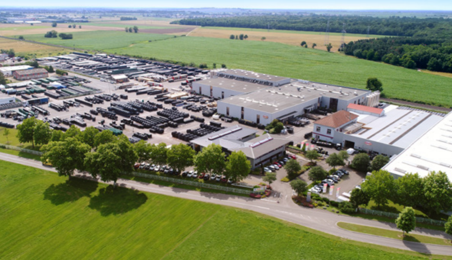
Site de production de Dachstein en Alsace
