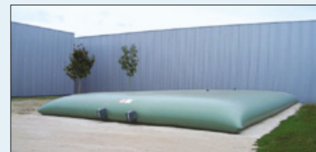
Réserve incendie - Hors Sol 240 m 3
