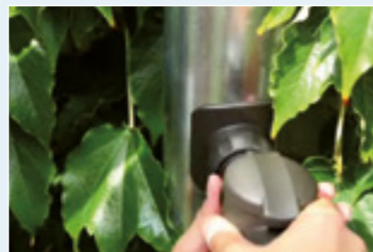
Mise en place du collecteur.
